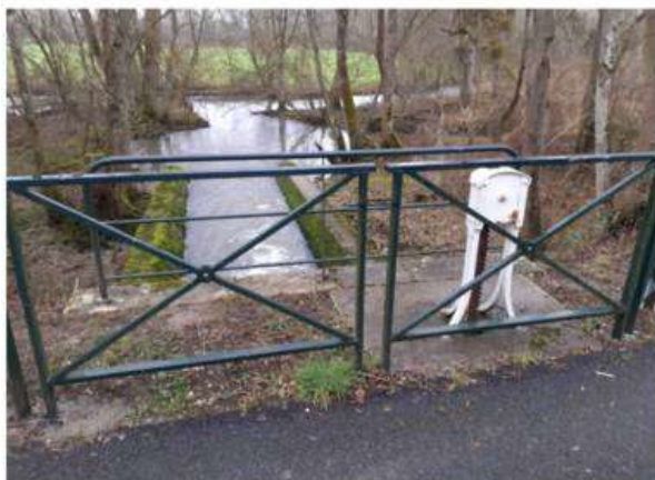
Figure 4-42 Vanne de la prise d'eau de la Tuilerie
