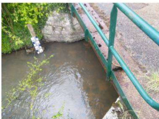
Figure 4-23 Confluence Pont Chevron : pont avec section calibrée et échelle limnimétrique
