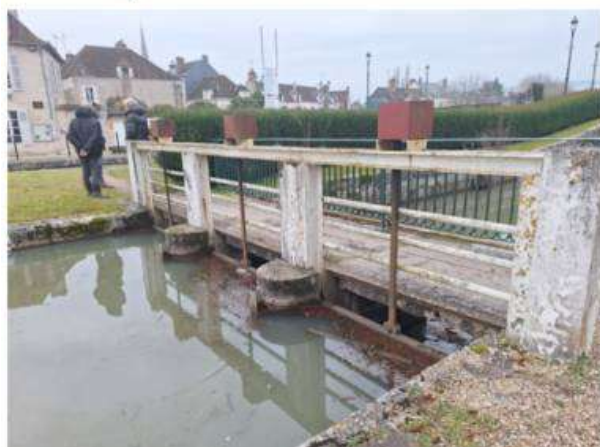
Figure 4-13 Vannes de la Fausse écluse de Briare
